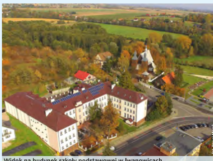
Widok na budynek szkoły podstawowej w Iwanowicach.
